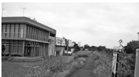
川和遊水地管理棟（右側が鶴見川）
