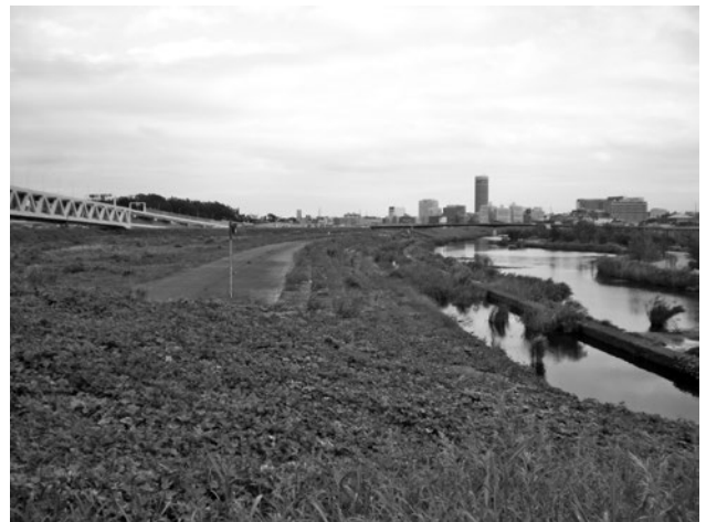
～越流堤（堤防の高さを低くして遊水地へ誘う）～
